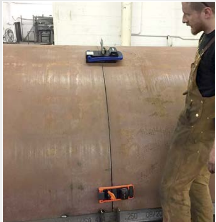
BEHÄLTERBAU – POLEN/ BRESLAU – MAREK
